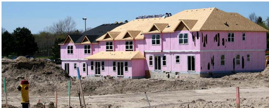
Le carton-fibre est plus long que la hauteur du mur, pour ainsi couvrir la partie de bois de la charpente du plancher qui donne sur l'extérieur. Vous le laissez donc dépasser de la longueur voulue pour qu'une fois le mur debout, le carton-fibre recouvre le 2 x 8 de la solive extérieure du
