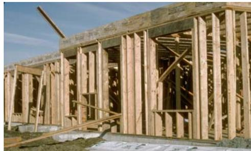
Pour les planchers, les solives forment la charpente où est installé le revêtement de sol. Le contreplaqué est vissé aux solives et recouvert d'un tapis, de bois franc ou d'un autre revêtement de plancher. Les solives sont fixées avec des clous et assemblées avec une lisse de contour, comme un mur couché. Le tout est ensuite assemblé et fixé sur la fondation. Une poutre de soutien sert habituellement à soutenir le centre du plancher de la maison.
